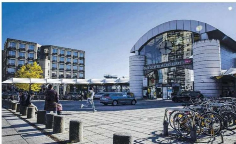
La gare TGV de Saint-Pierre-des-Corps voit plus de deux millions de voyageurs transiter chaque année.
