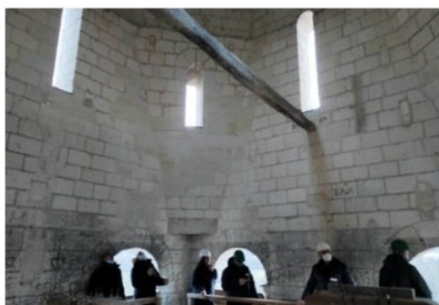
Dans la flèche restaurée du grand clocher de l'église Saint-Laurent.
