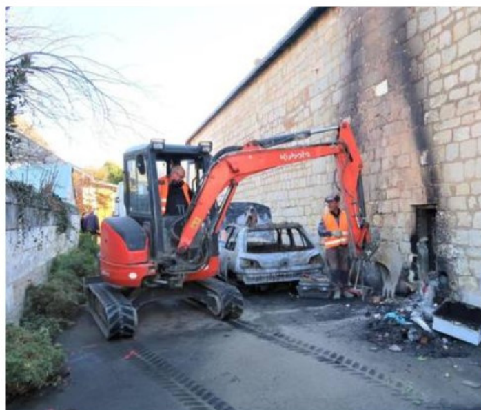
Une voiture et un compteur de gaz, situés à proximité du domicile de Sophie Métadier, sont complètement carbonisés.
